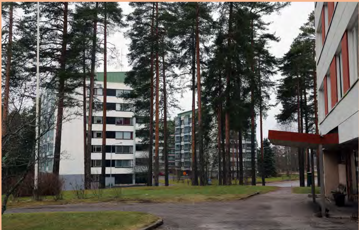
Näkymä Salpakankaantie 3 ympäristöstä. Talojen välissä kohoavat suuret havupuut korostavat alueen metsäistä luonnetta.
