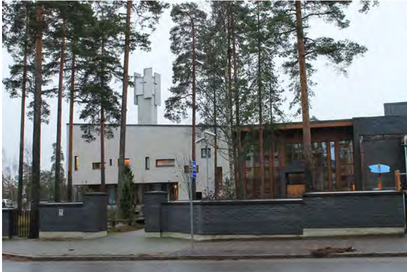
Sovituksenkirkon pihalla kasvavat männynt korostavat rakennuksen vertikaalisia linjoja.
